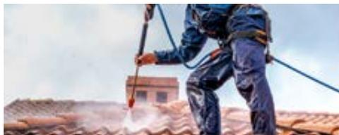
L'Agence de l'énergie utilise un produit 3 en 1 qui assainit les tuiles et retarde le développement des mousses, détruit les germes présents dans les matériaux et minéralise les supports.
